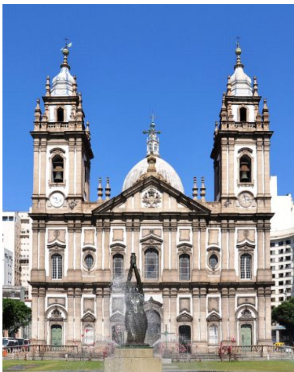
Figura 2 – Fachada da segunda igreja de Nossa Senhora da Candelária, no Rio de Janeiro. Disponível em www.candelariario.org.br .
